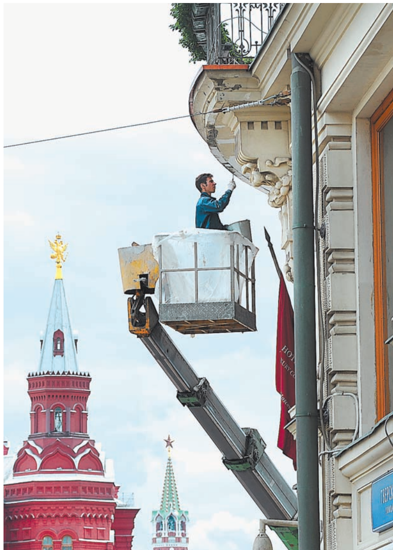
К концу 2015-го великолепно выглядеть будут 4076 зданий.
