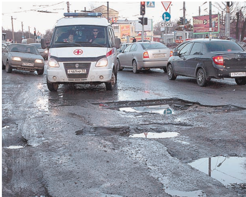
Весной низкое качество укладки и ремонта дорог становится особенно заметным: асфальт будто сходит вместе со снегом.
