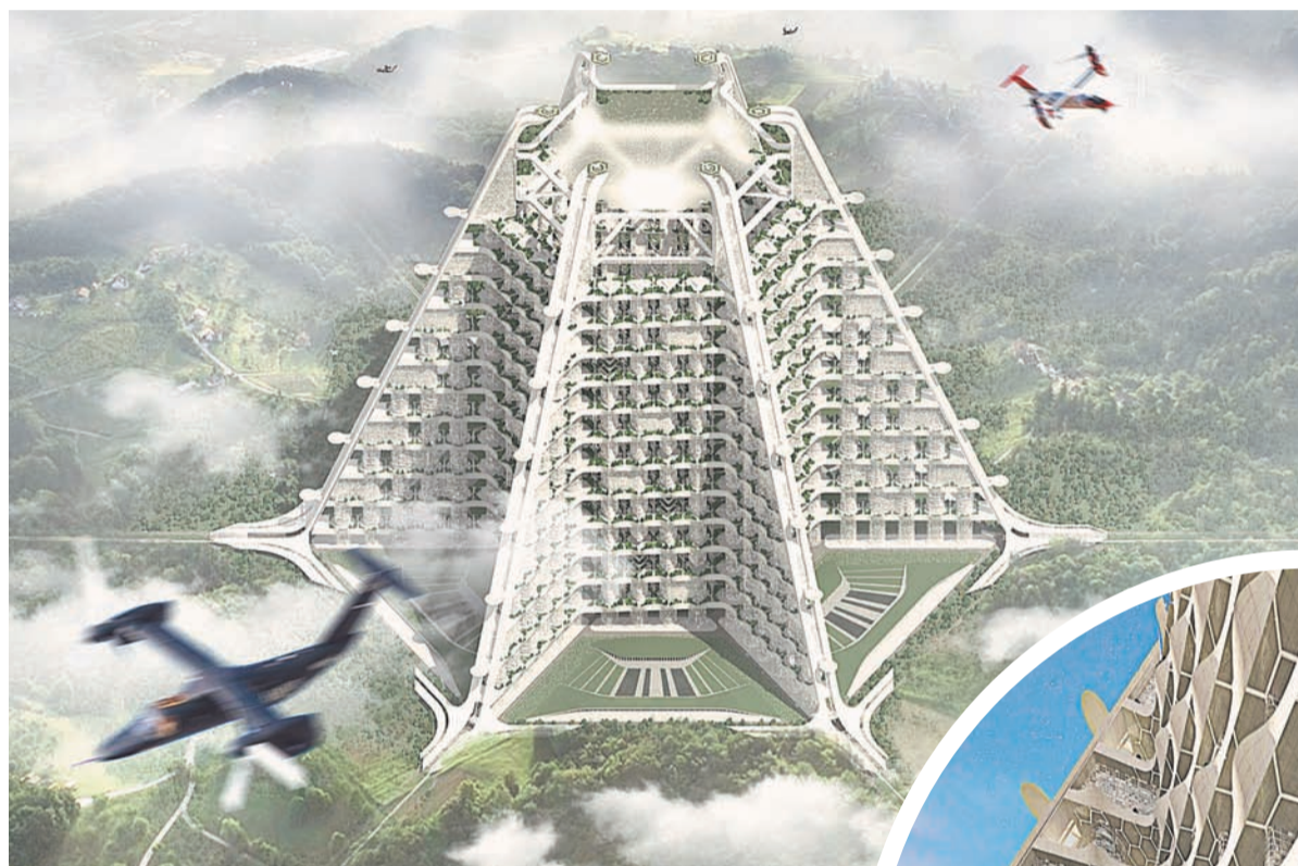
Вертикальный город будущего, проект архитектора Филиппа Никандрова («ГОРПРОЕКТ»). Высота - 1111 м, число жителей - 350 тыс. Состоит из башен-модулей высотой 16-20 этажей. Используются ветрогенераторы, солнечные батареи, автоматизирован сбор дождевой воды.
