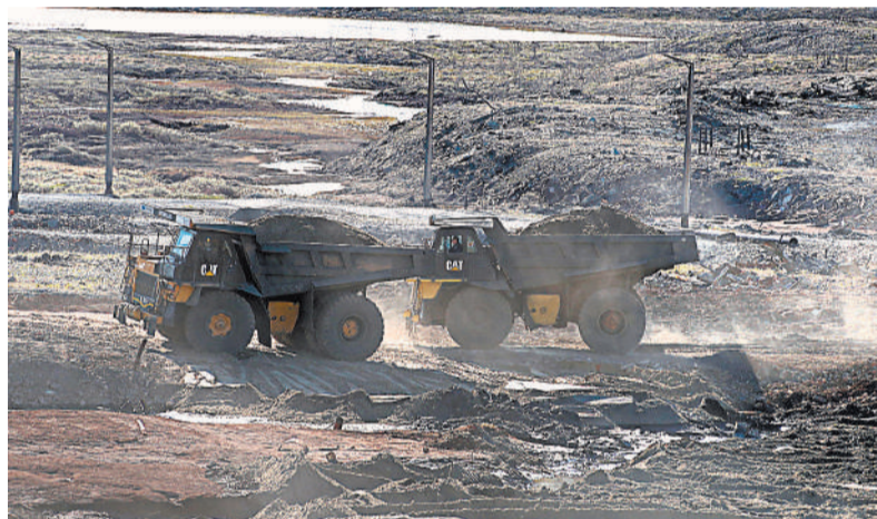
31 мая. Автомобили ТЭЦ-3 вывозят загрязнённый грунт.
