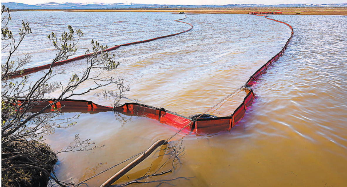
Бонами локализовали разлив топлива в реке Амбарке.
