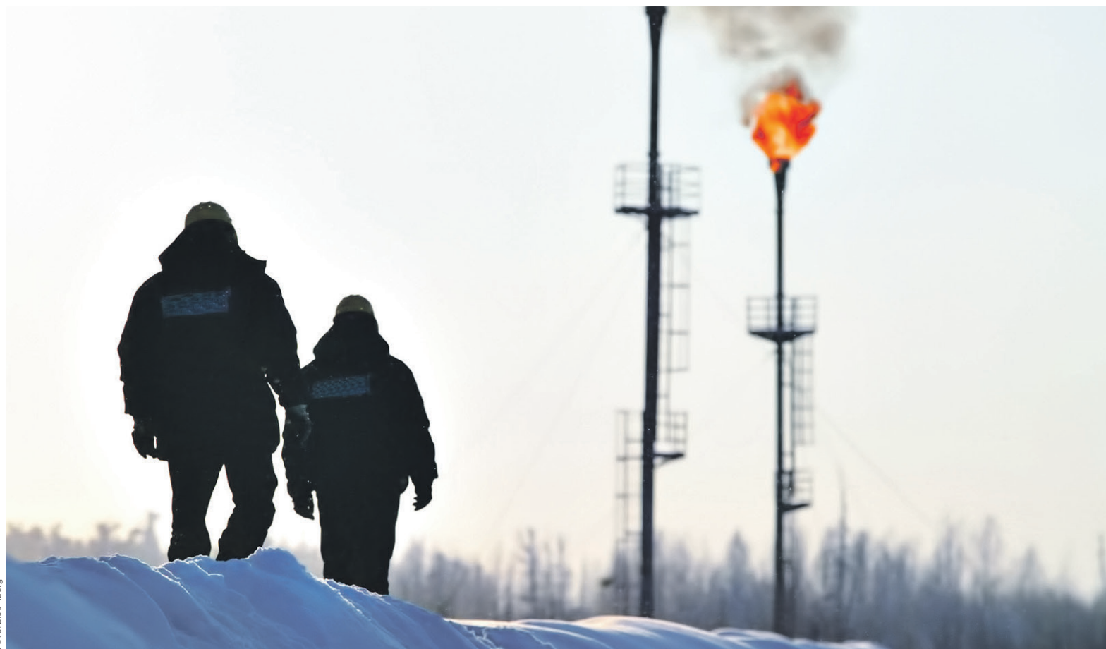
Борулахский нефтегазовый участок привлекателен тем, что мимо него проходит нефтепровод Восточная Сибирь — Тихий океан, по которому нефть направляется в Китай, и рядом должен пройти газопровод «Сила Сибири»
