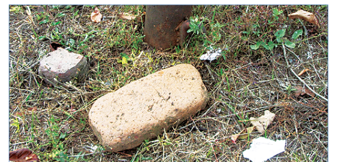
Кирпич на обочине ул. Трудовая со стёртыми от времени гранями.
