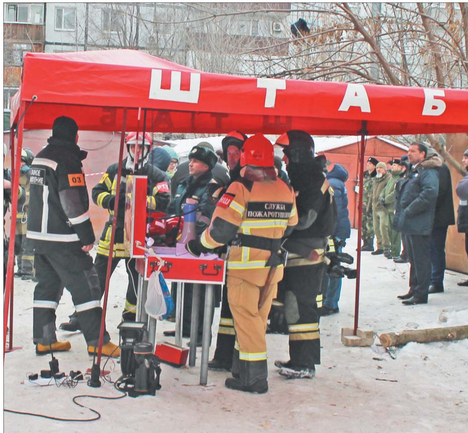
Двое суток на месте происшествия работают спасательные службы. Ведутся поиски пропавших во время обвала здания.
