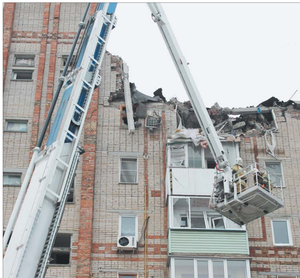
Страшный взрыв произошел в многоэтажке на ул. Хабарова, 16. Разрушены 8 и 9 этажи.
