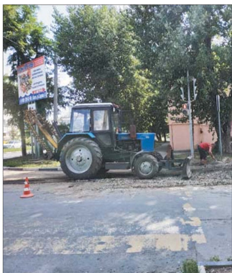
Огромную яму засыпали щебнем и разровняли.
