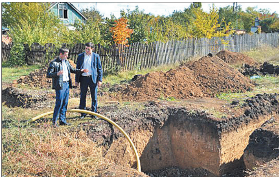
В п. Равнинный активно ведутся работы по подключению газа.
