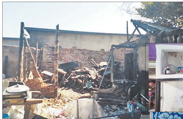
Двое детей и мать-одиночка вынуждены жить в разрушенном аварийном доме.
