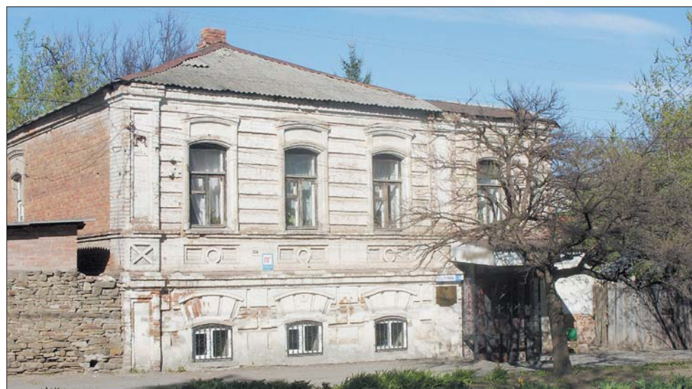
В Александровске-Грушевском дома строились с полуподвальным этажом, там спасались от летнего зноя.
