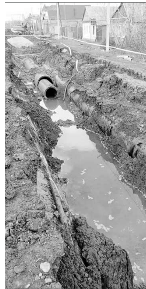
Старая труба на Дачной протекает минимум в четырех местах.
