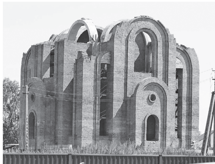
Средств хватило пока только на стены, а завершить возведение крыши все никак не получается.
