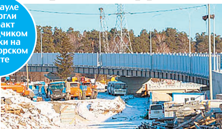
Наземная часть объекта завершена более чем на 80%.
