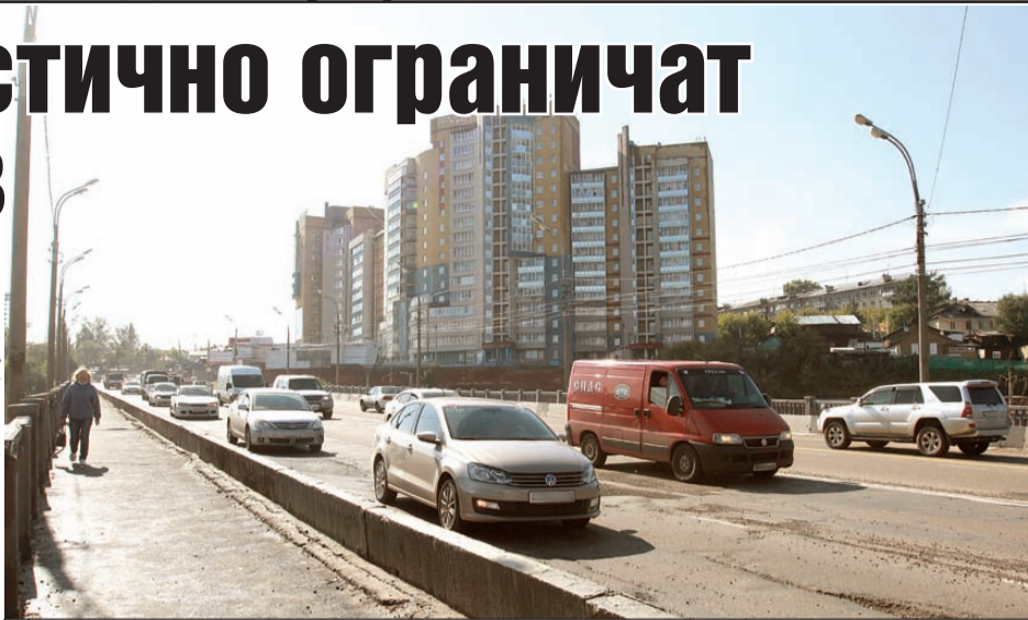
Речь идет о путепроводе: четырехполосное движение станет двухполосным - по одной в каждую сторону.
