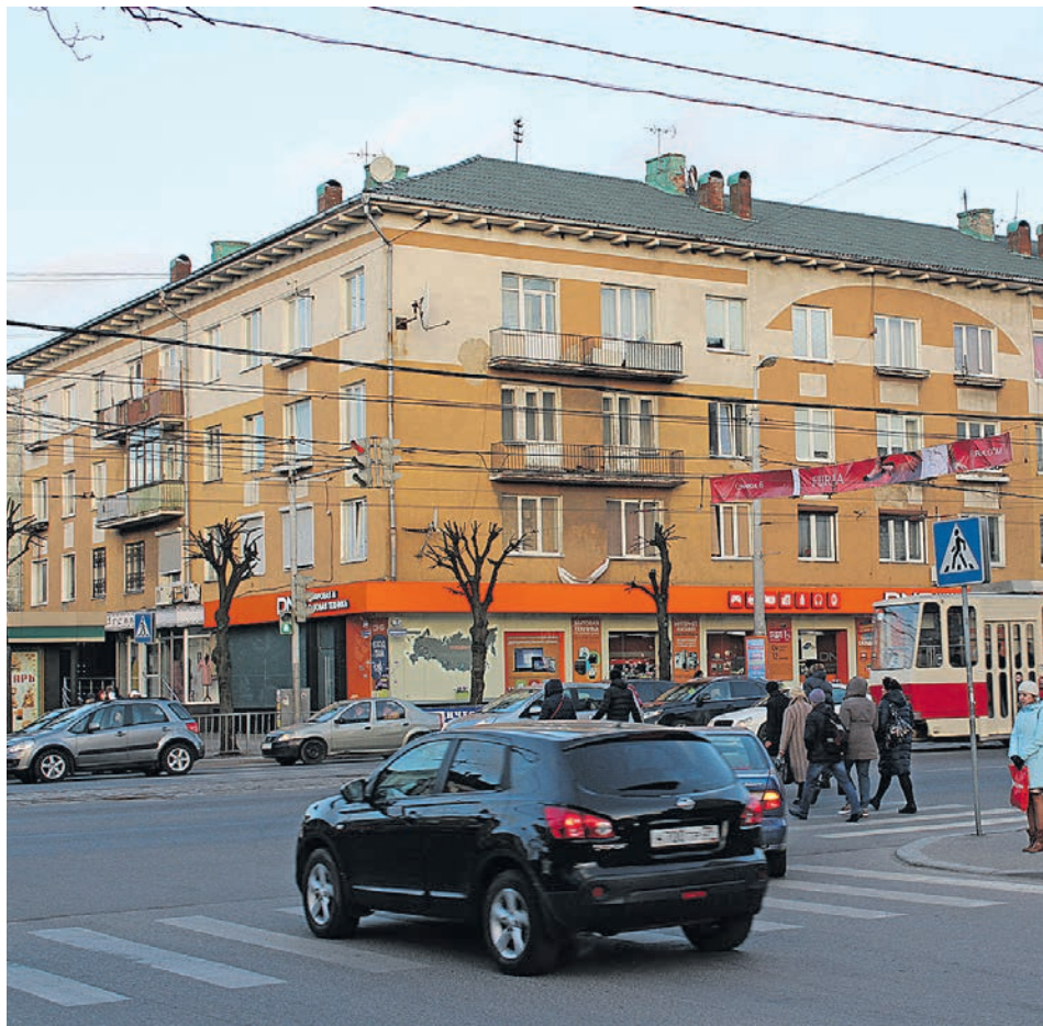
Предложения по изменению внешнего вида жилого дома на Ленинском проспекте можно присылать до 15 апреля. Участвуйте!
