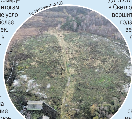
Завершение работ по рекультивации запланировано на декабрь 2023 года.
