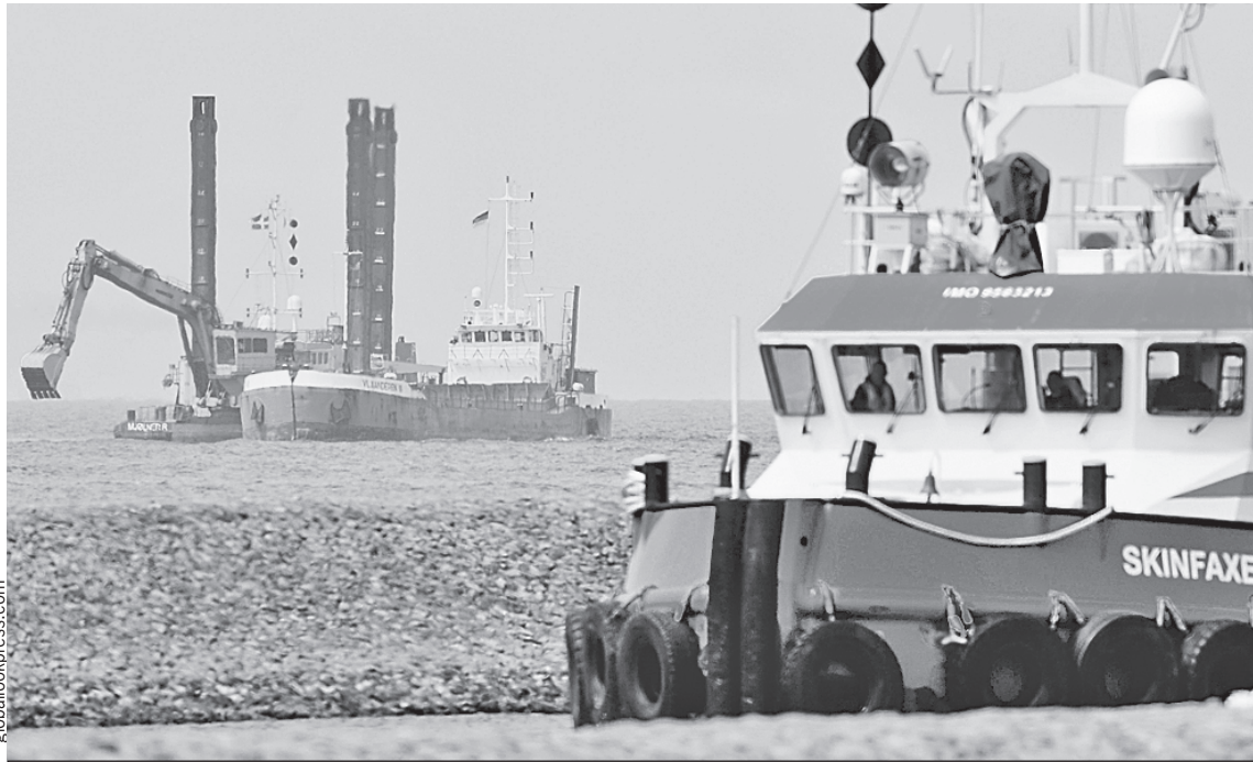
Пока получают разрешения на прокладку «Северного потока-2» (осталась только Дания), в районе немецкого Грайфсвальда уже идут работы по расчистке «фарватера» для будущего газопровода.
