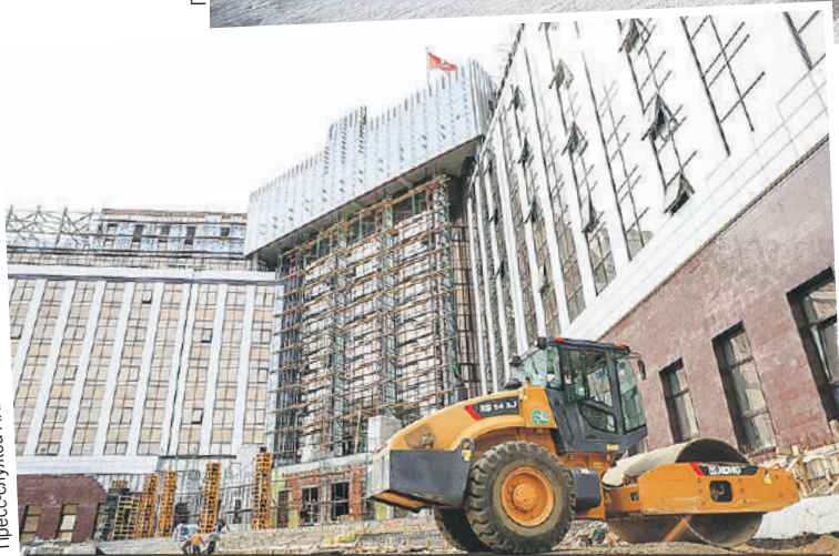
Общая площадь восьмиэтажного здания суда составляет более 28 тысяч квадратных метров.
