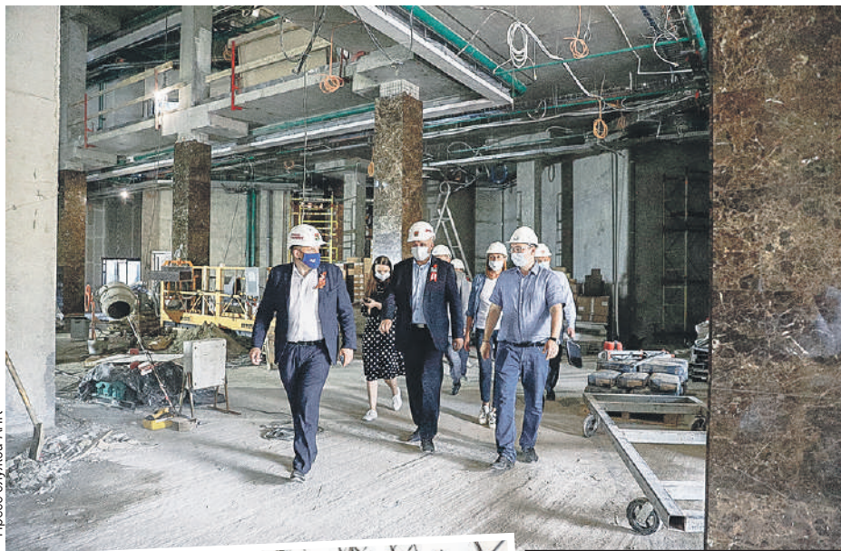
Сергей Цивилев проинспектировал стройку.
