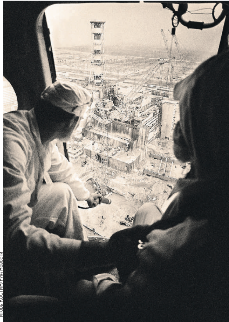
27 апреля 1986-го дозиметристы постоянно измеряли радиацию в прямой видимости разрушенного четвертого блока.
