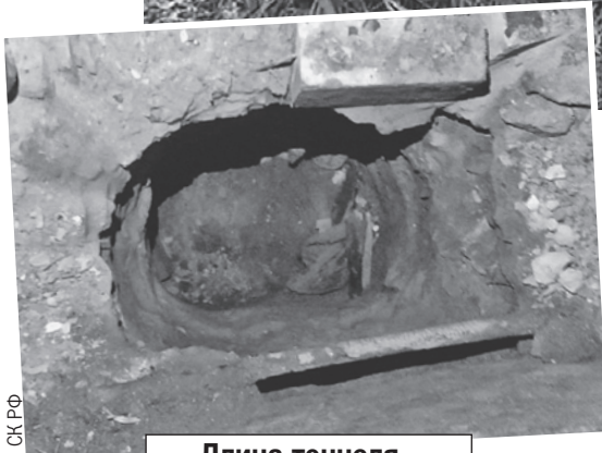
Длина тоннеля - около 65 метров.
