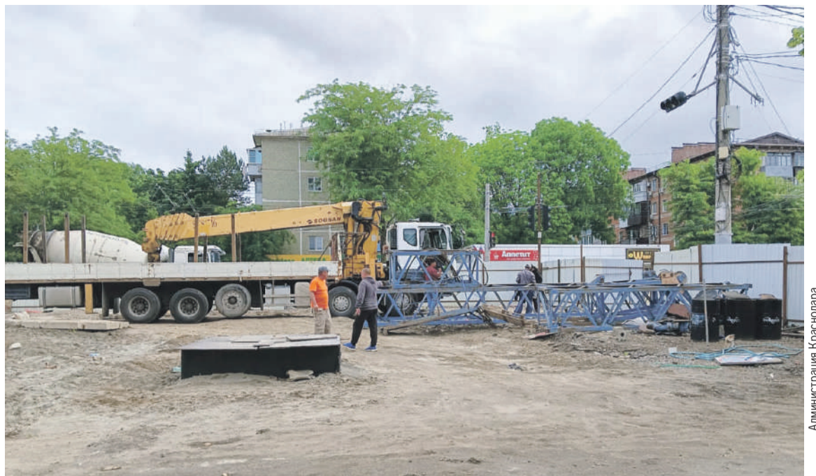
На участке кипит работа.
