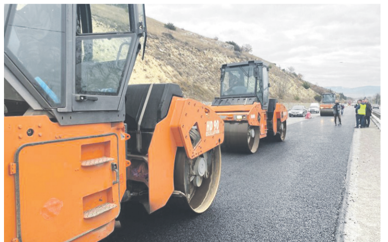
Предстоит построить и отремонтировать 927 км автомобильных путей.
