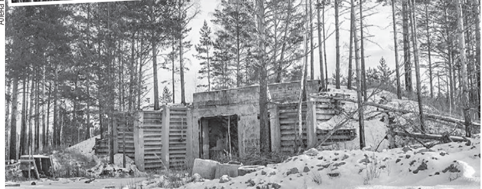
Сооружения удивительны тем, что с неба они не заметны. Найти самим вход в подземелья базы сложно.
