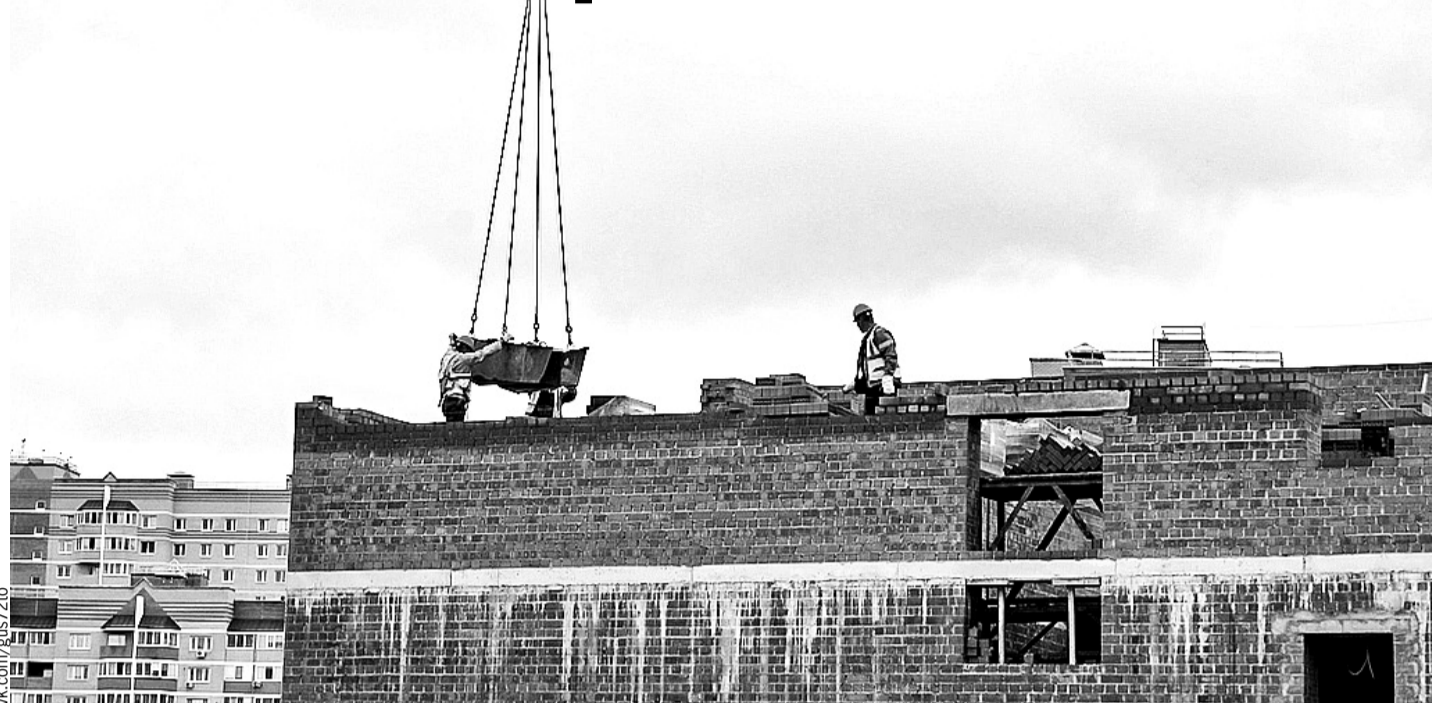
В Тюмени активно ведется строительство школы в Ямальском-2.
