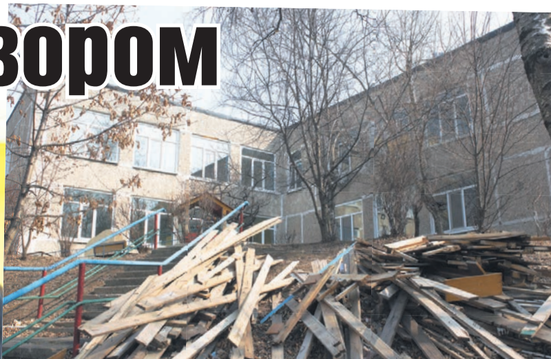
Большую часть строительных работ в детском саду на Тобольской уже завершили.
