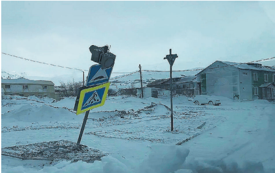
Дома вибрировали, кровли трещали под напором ураганного ветра.
