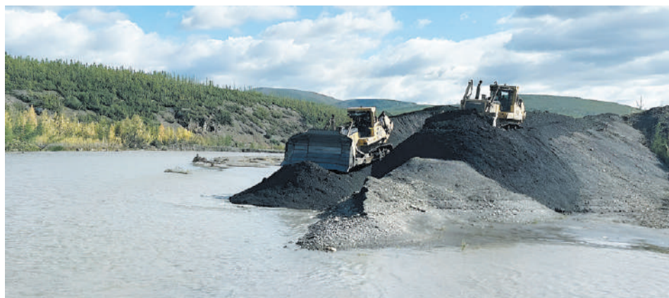
На участках трассы постоянно идут ремонтные работы.
