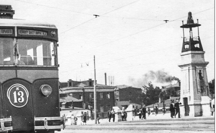
□ Троллейбус ЛК-1 на Тверском путепроводе. 1934 г.
