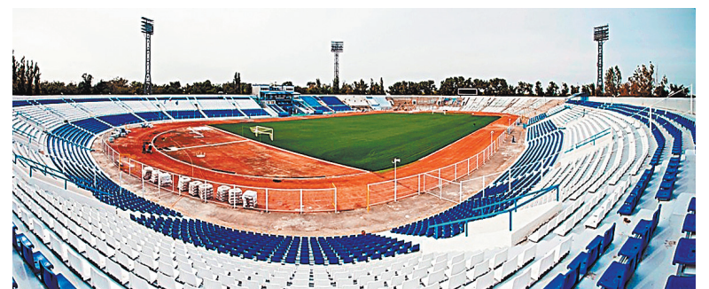
После реконструкции стадион «Центральный» в Астрахани принял современный вид и готов к проведению финала Кубка России текущего розыгрыша.
