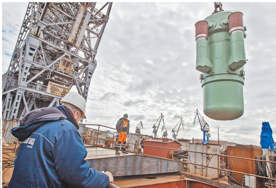
Строящиеся на Балтийском заводе атомные реакторы «Арктика», «Сибирь» и «Урал» оснащаются новой реакторной установкой РИТМ-200.
