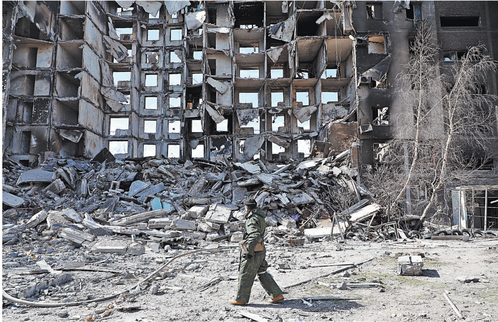
Те кварталы Мариуполя, где шли ожесточенные бои, жилыми больше не назовешь — кругом обгоревшие, разрушенные или обвалившиеся многоэтажки с пустыми оконными проемами.
