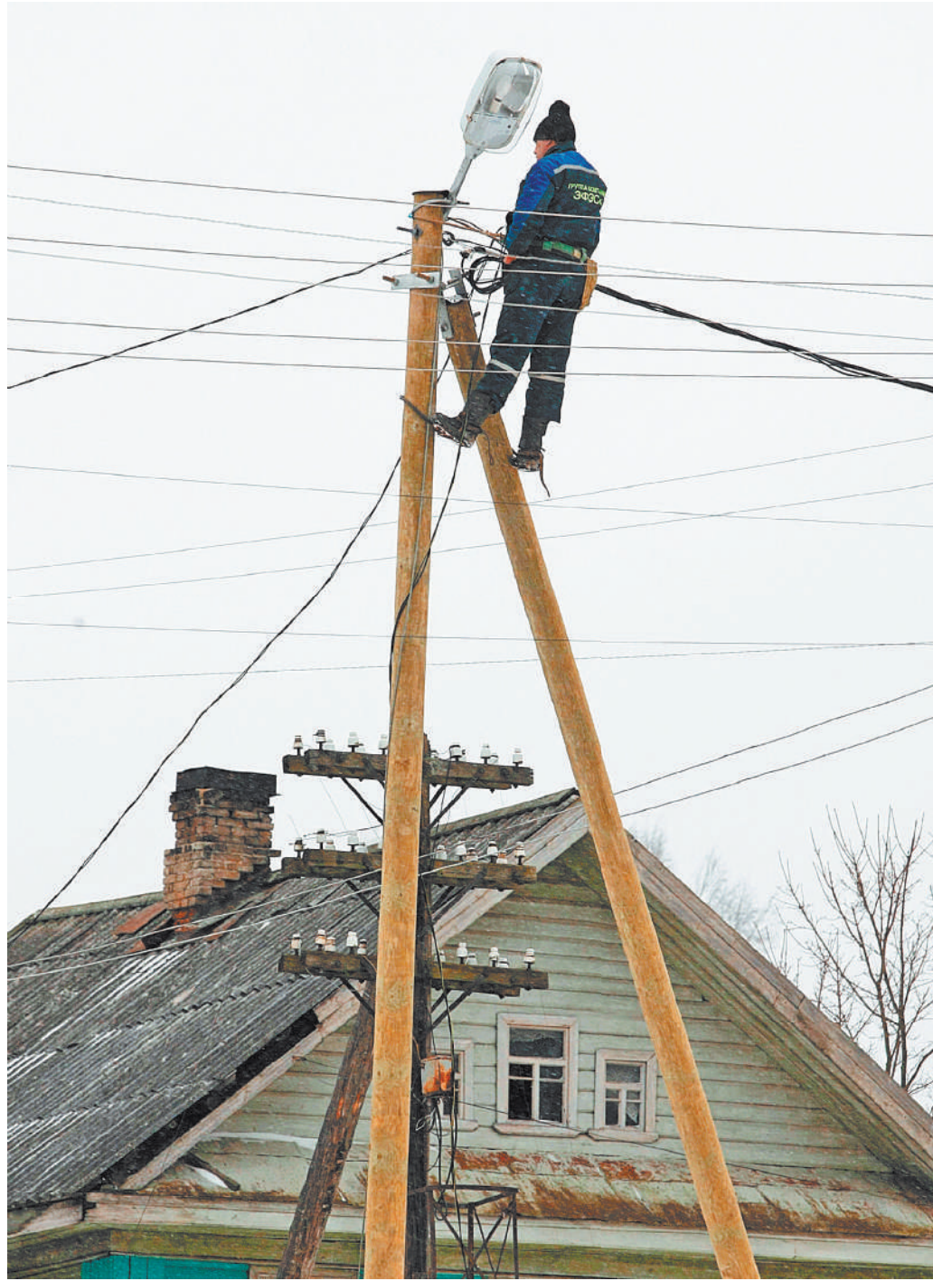
Монтаж электросетевого оборудования и подведение провода оплачивается заказчиком работ.
