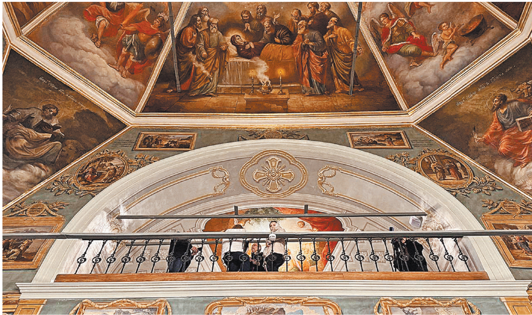
В церкви Петра и Павла на Новой Басманной улице восстановили и обновили 40 сюжетных росписей, спрятанных под слоями краски и штукатурки.
