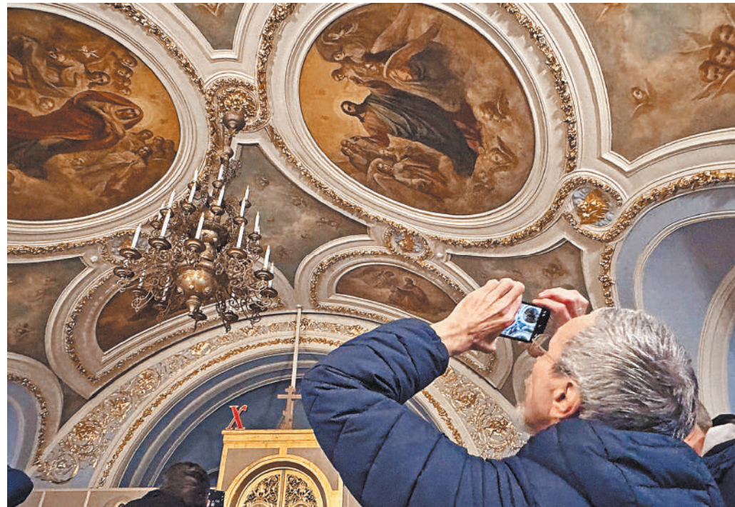
Реставраторы работали в храме шесть лет, причем как снаружи, на фасаде, так и внутри, над интерьерами.
