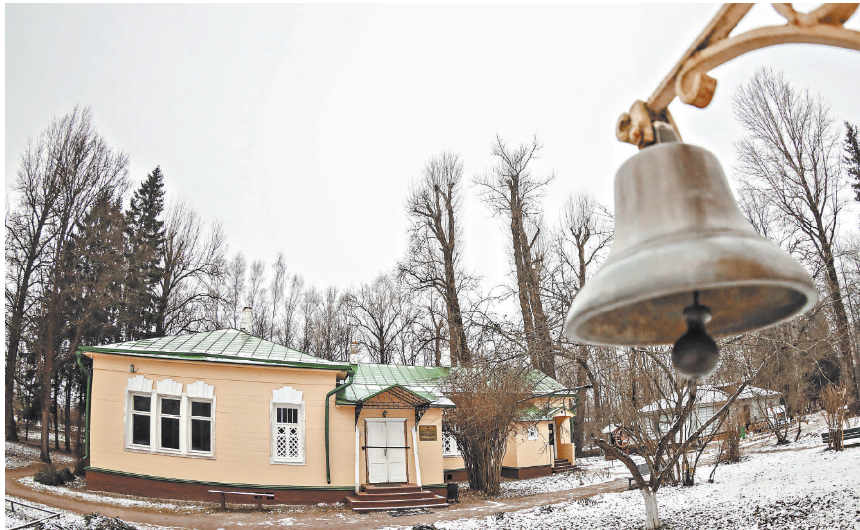
Главный усадебный дом сейчас на реставрации. Обновленным он предстанет уже в мае 2025 года — к фестивалю «Мелиховская весна».
