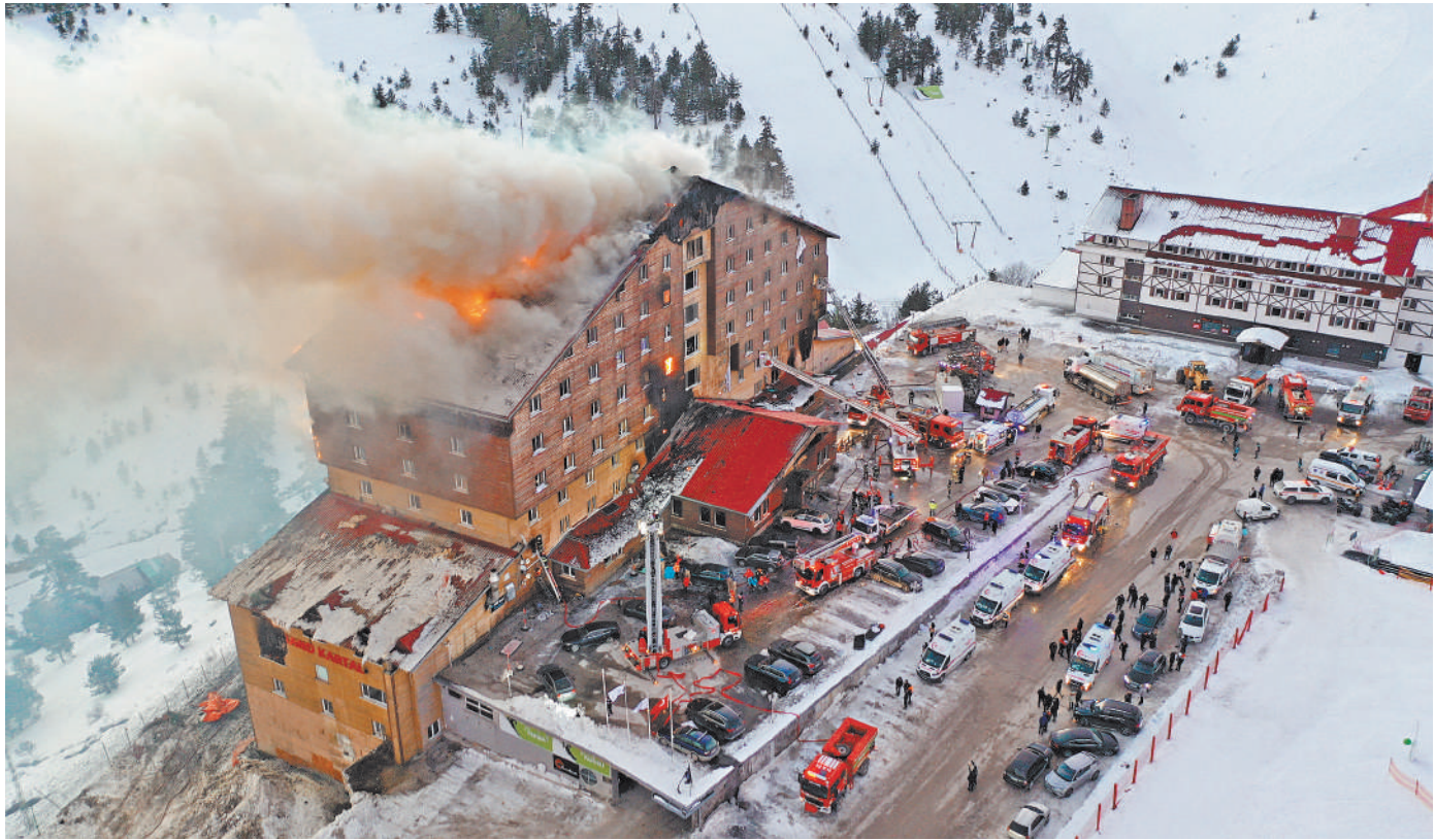
Пожар быстро охватил весь отель из-за многочисленных деревянных элементов отделки. По свидетельствам очевидцев, пожарная сигнализация в гостинице не работала.
