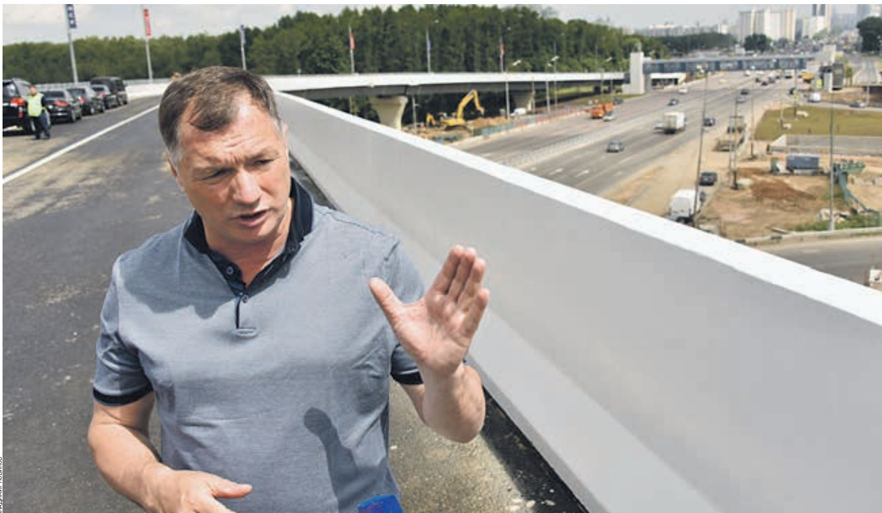
Вчера 11:15 Заммэра Москвы по вопросам градостроительной политики и строительства Марат Хуснуллин убежден: новая эстакада снимет напряжение на этой развязке
