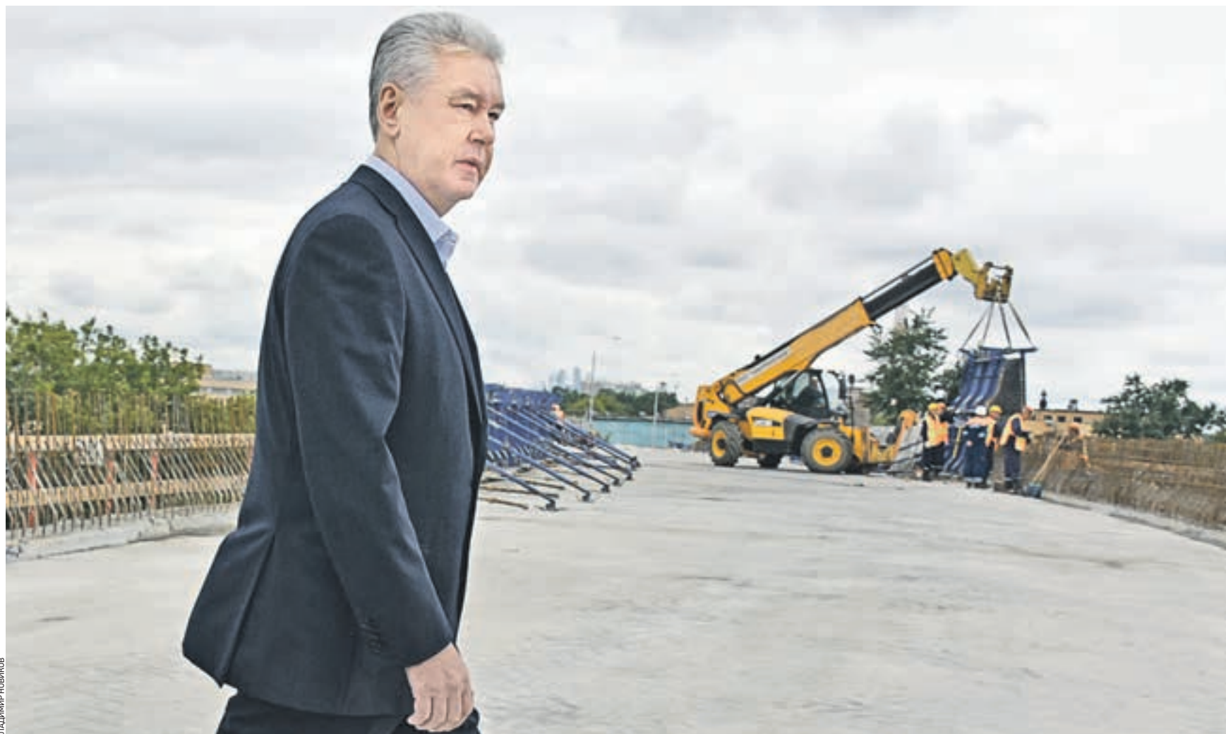
Вчера 11:08 Мэр Москвы Сергей Собянин осматривает строящийся путепровод, который уже в сентябре текущего года соединит Люблинскую улицу и Остаповский проезд
