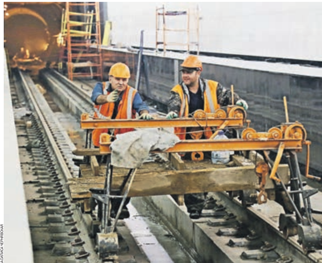
5 августа 2017 года. Рабочие Константин Петров (слева) и Сергей Старенко проводят укладку рельсов и проверку путей на строящейся станции «Шелепиха»
