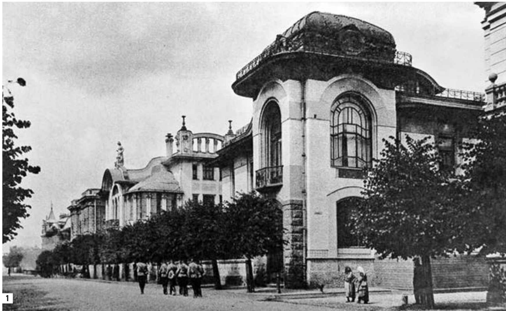
Фото особняка на Поварской, 44, начала XX века из архива архитектора Бориса Могинова (1) 17 октября 11:32 Скульптор Владимир Усов вносит последние штрихи в модель скульптуры Авроры (2)
