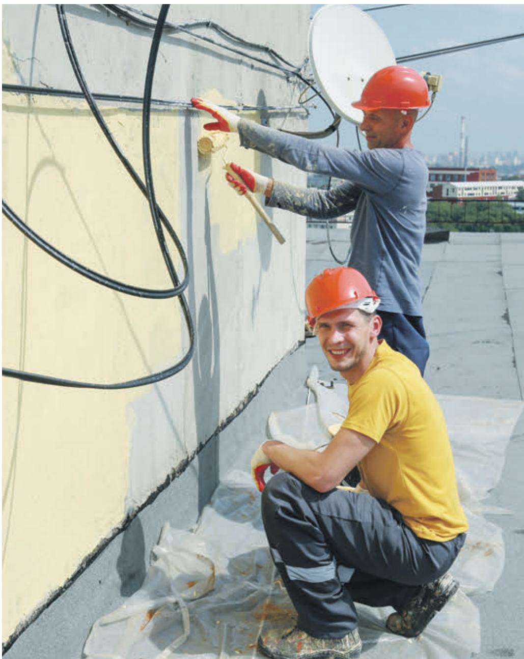
27 июля 2018 года. Рабочие ГБУ «Жилищник района Котловка» красят машинное отделение лифта в ходе выполнения работ по капремонту дома № 15, корпус 5, на Нагорной улице
