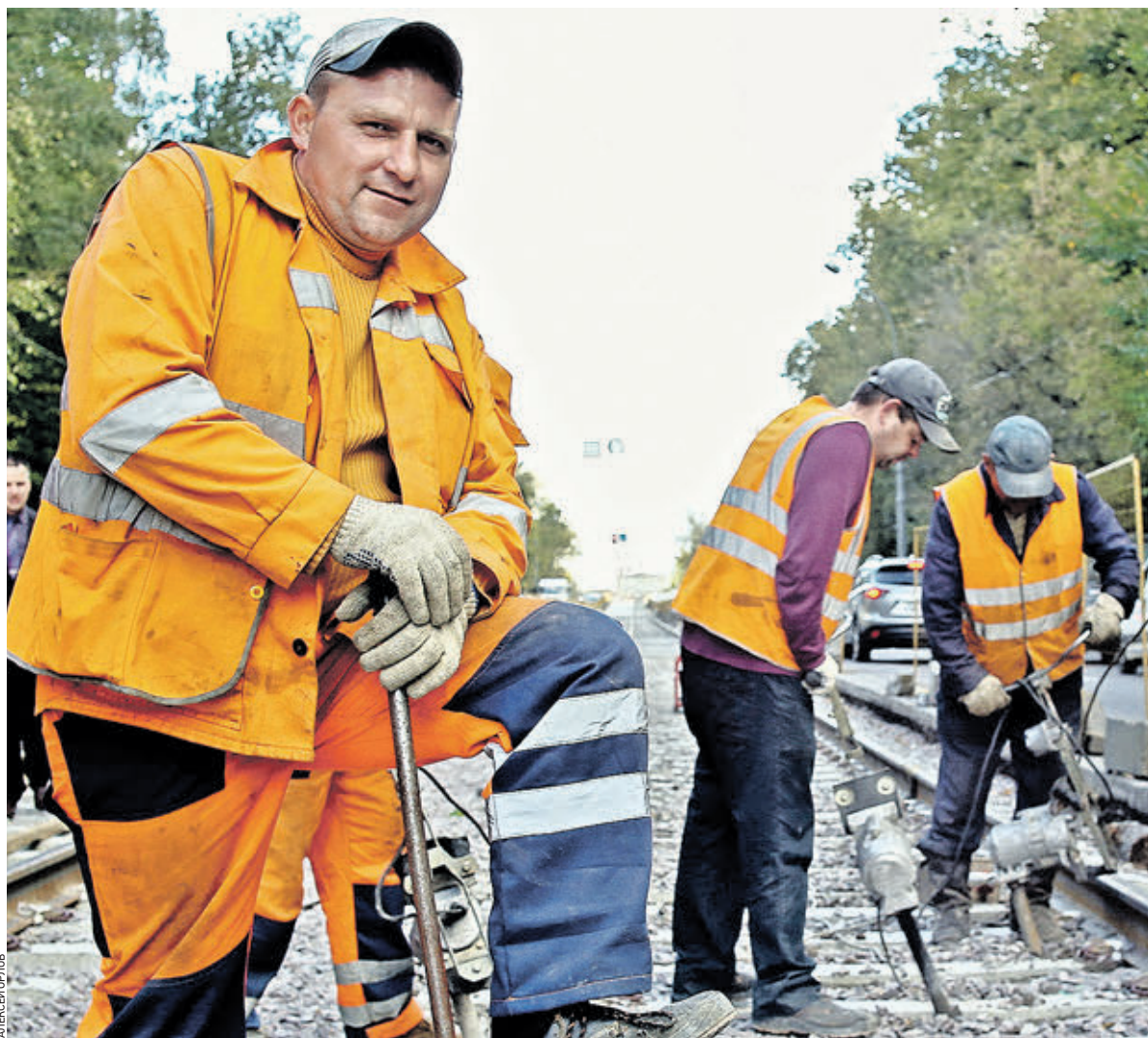
18 сентября 2018 года 15:43 Монтер путей Александр Борисов устроил небольшой перерыв после физической тяжелой работы со шпалоподбойкой
