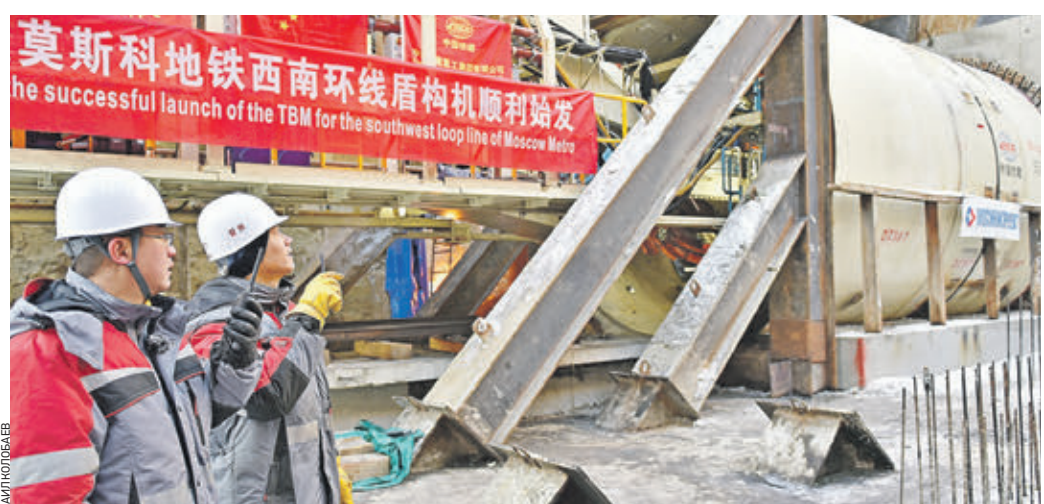
25 января 2019 года 11:12 Момент запуска тоннелепроходческого щита «Мария» на станции «Аминьевское шоссе»
