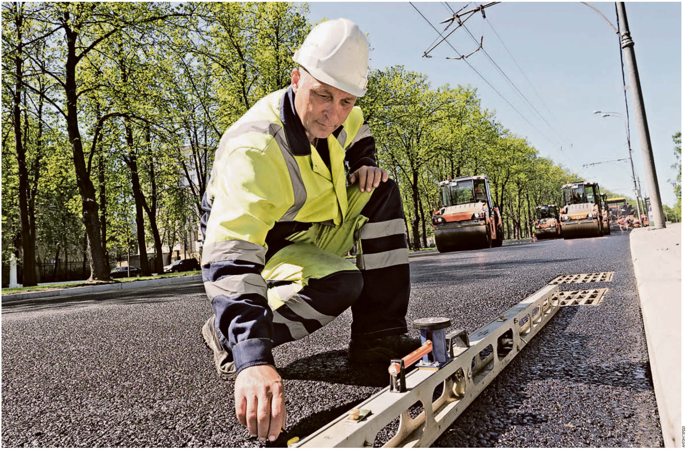
15 мая 2017 года. Замена асфальтового покрытия на улице Косыгина. Заместитель начальника участка ПК Север ГБУ «Автомобильные дороги» Владимир Прокошев проверяет ровность дороги
