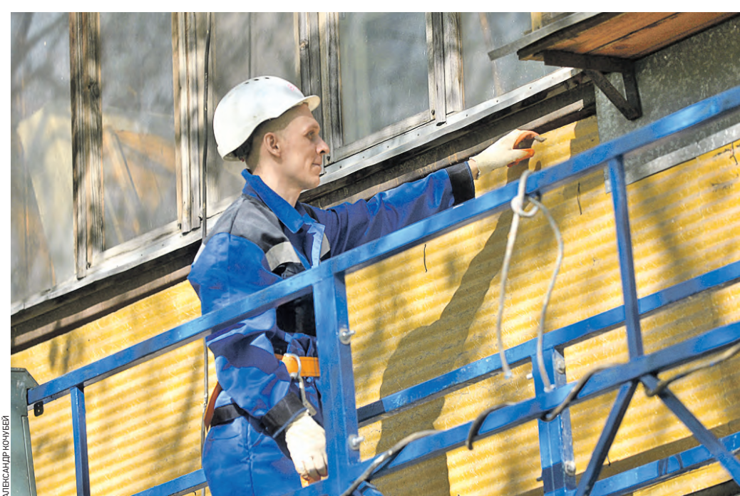
13 мая 16:40 Фасадчик Антон Козин во время работ по снятию облицовочной плитки на доме по адресу: улица Россошанская, 1, корп. 1, где проводится капитальный ремонт здания
