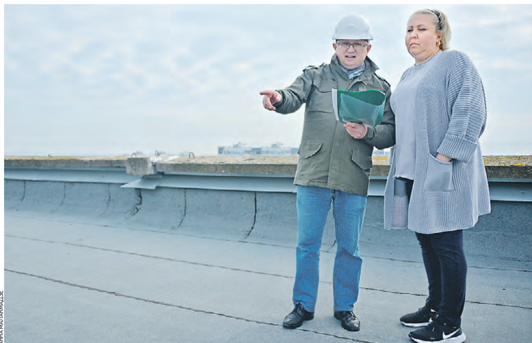
19 сентября 10:47 Руководитель аппарата совета депутатов муниципального округа Орехово-Борисово Южное Денис Беляевский и начальник производственно-технического отдела ГБУ «Жилищник района Орехово-Борисово Южное» Елена Талесник осматривают кровлю крыши дома № 46, корпус 1, на Воронежской улице
