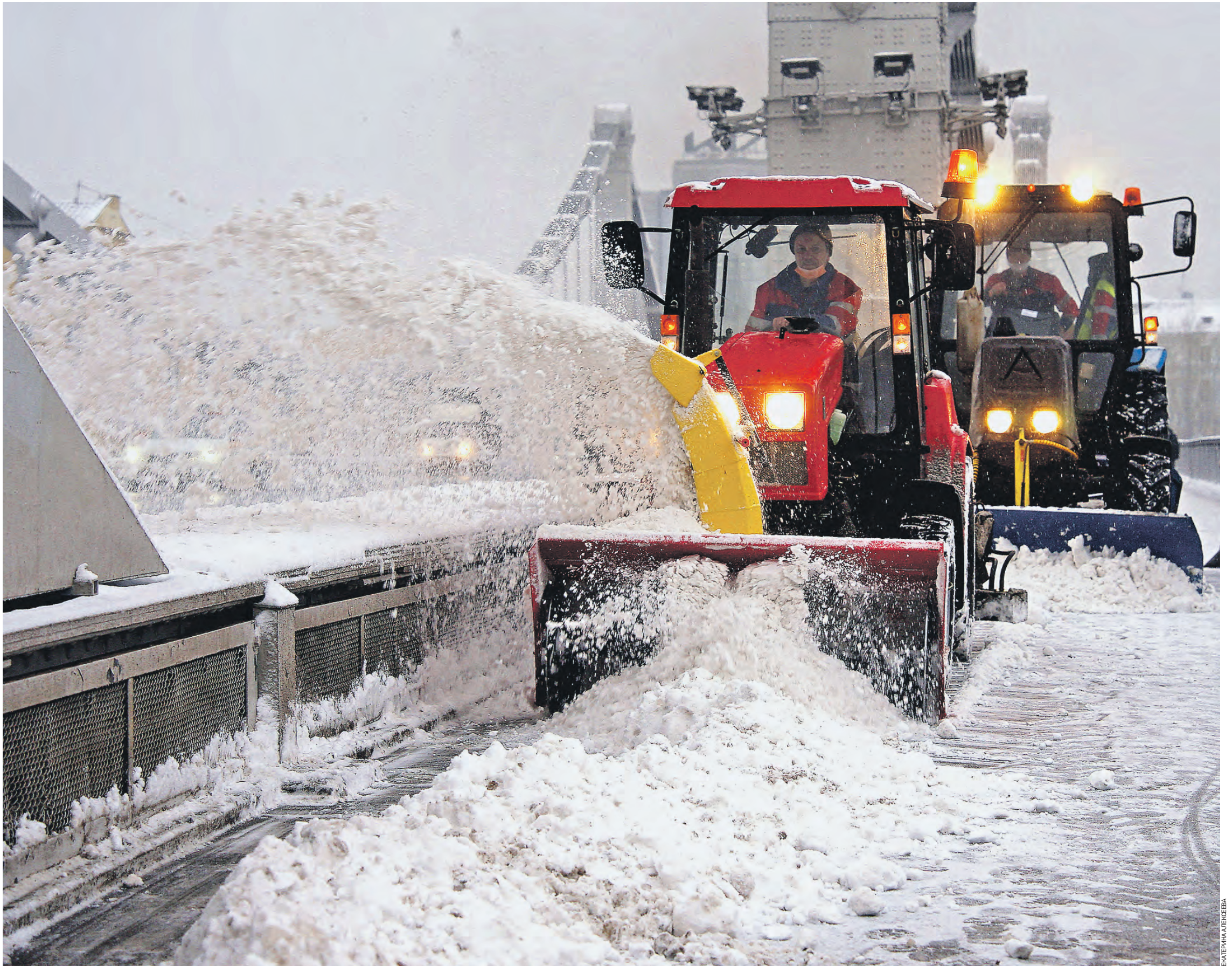
7 декабря 2022 года. Спецтехника ГБУ «Горьmost», оснащенная ротором и щетками, очищает от снега пешеходную зону Крымского моста. К снегоуборочным работам коммунальщики готовятся заранее, получив точные метеосводки
