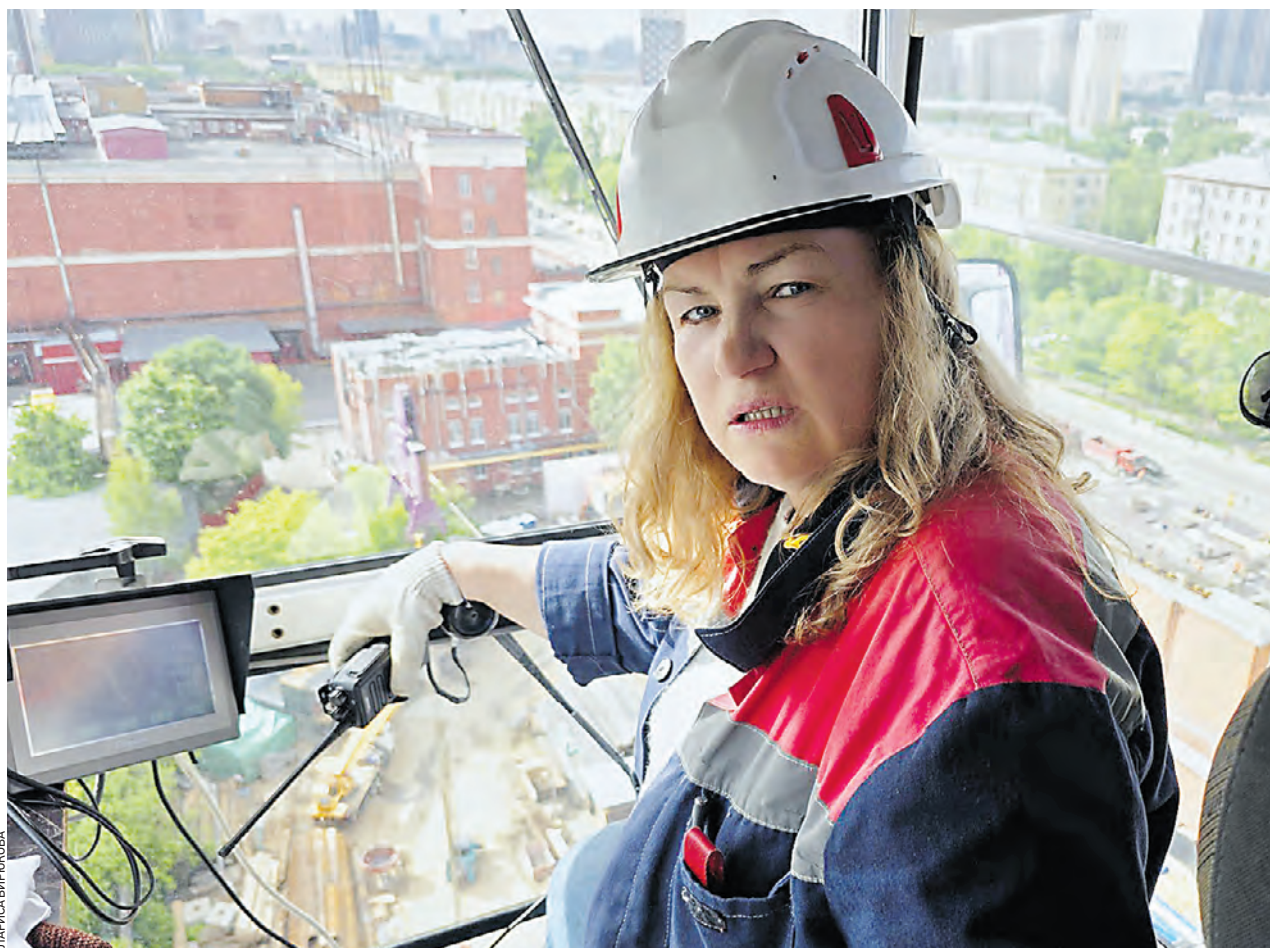
1 июня. Машинист башенного крана Лидия Юнку управляет техникой с большой высоты: из кабины над стройплощадкой
