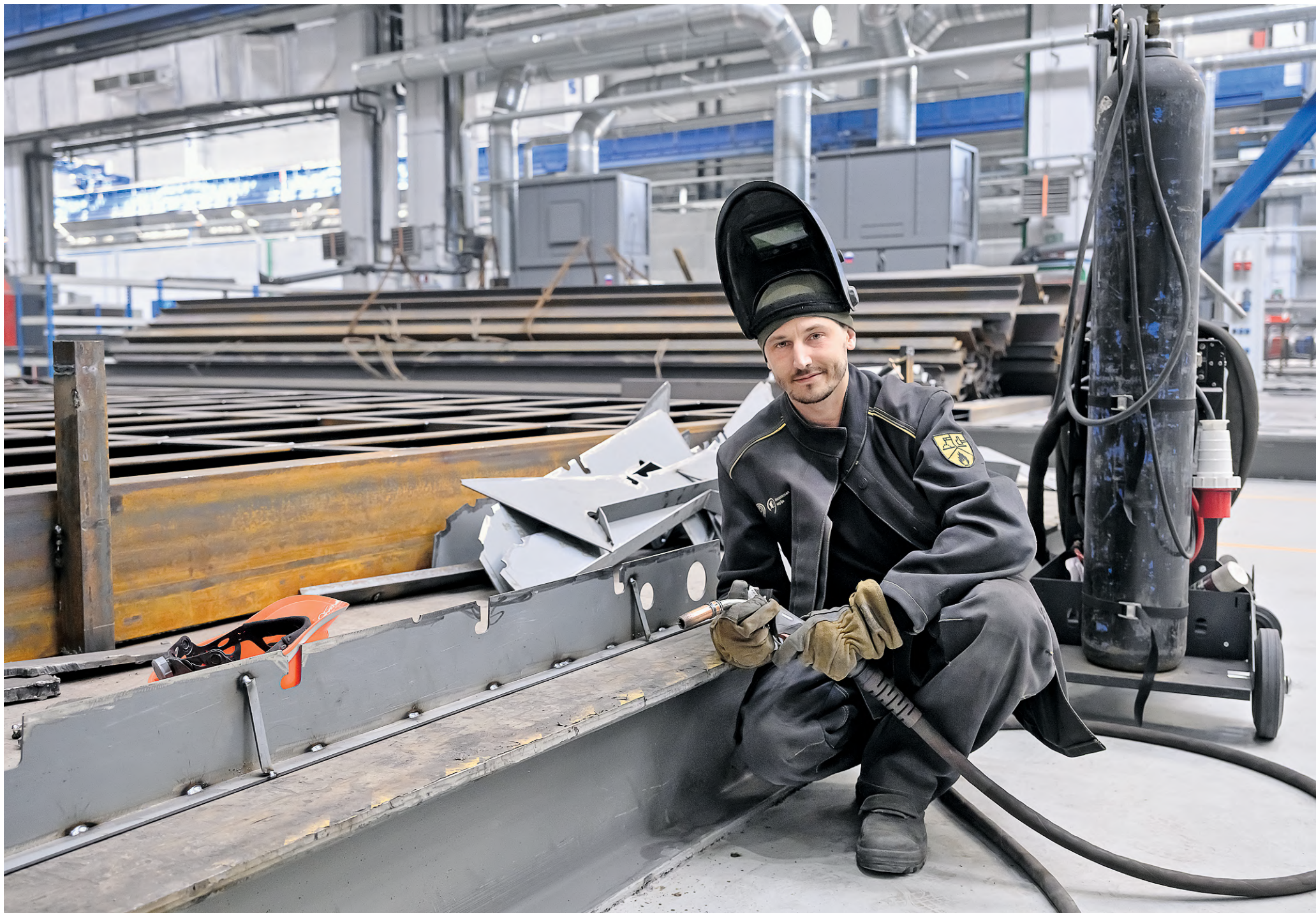
27 марта. Сварщик Илья Приколотин варит корпус будущего электрического речного судна «Москва 1.0» на Московской судостроительной верфи. фото: дмитрий дубинский
