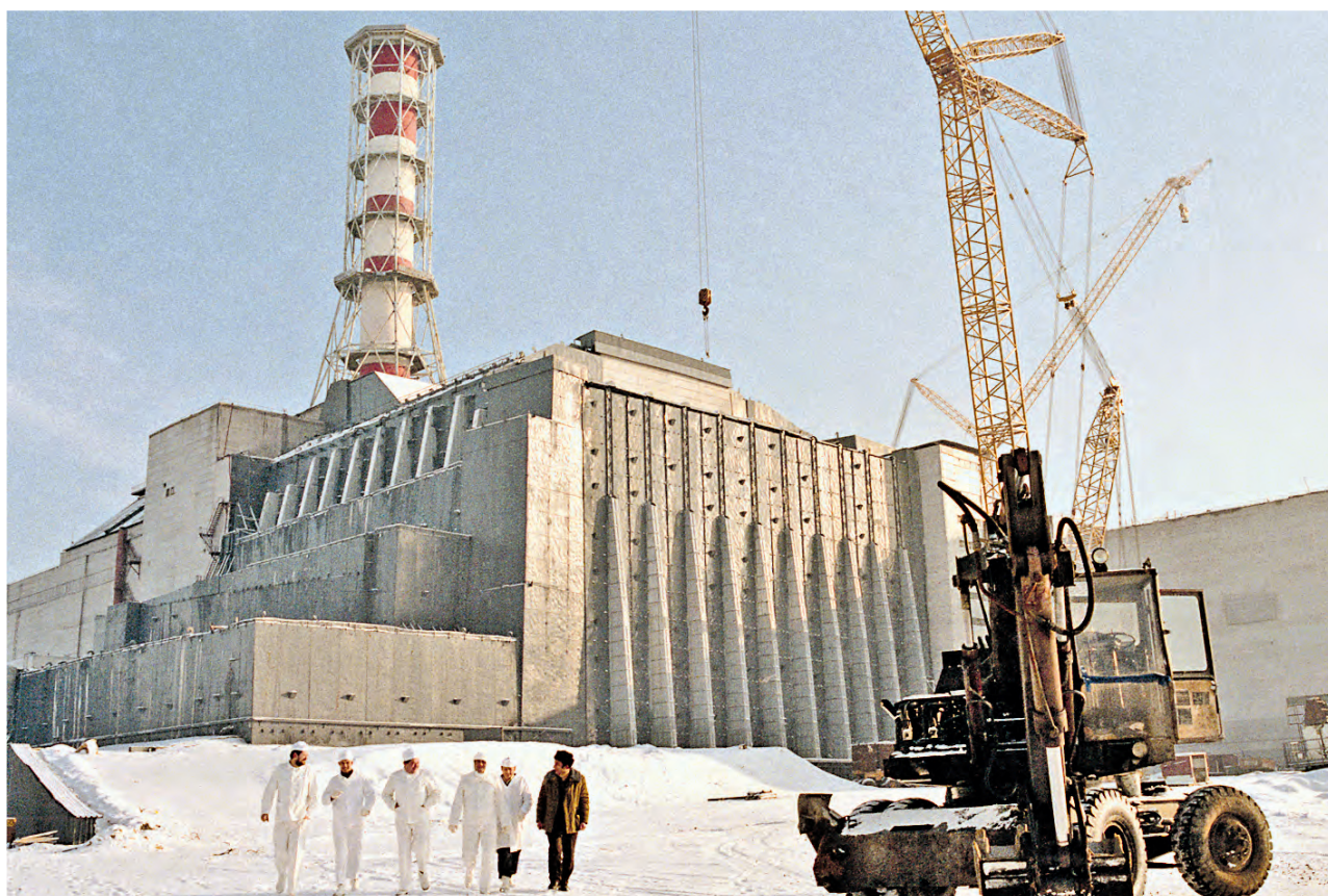
Февраль 1988 года. Защитное сооружение «Укрытие» над разрушенным четвертым энергоблоком Чернобыльской АЭС, предназначенное для изоляции радиоактивных остатков, было построено в рекордно короткие сроки
